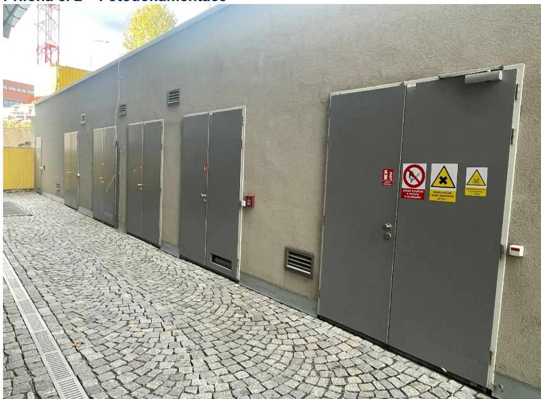
Místnost pro dočasné umístění vyřazeného elektrozařízení a chemie
